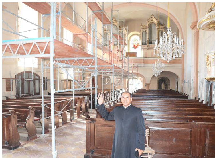
▲ Pfarrer Yohanu Katru in seiner Kirche, deren Innenraum derzeit für die laufenden Arbeiten eingerüstet ist.
