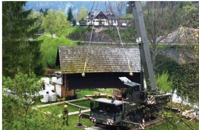
**Renovierung der Bootshütte.** Mit Unterstützung des Bundesheeres wurde im April 2014 die Bootshütte des WasserClusters Lunz renoviert. Die morschen Piloten wurden entfernt, neue wurden geschlagen – bis zu sieben Meter tief. Zu diesem Zwecke musste die ganze Hütte in die Luft gehoben und zwischenzeitlich aufs Festland gebracht werden.
