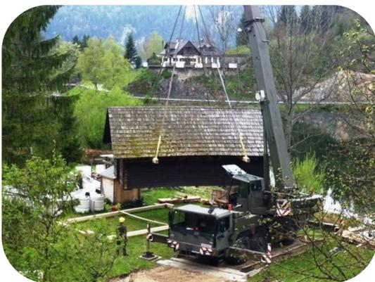
**Renovierung.** Mit Unterstützung des Bundesheeres wurde im April die Bootshütte des WCL renoviert. Die morschen Piloten wurden entfernt, neue wurden geschlagen – bis zu sieben Meter tief. Zu diesem Zwecke musste die ganze Hütte in die Luft gehoben und zwischenzeitlich aufs Festland gebracht werden.
