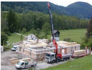
Umbau der alten Biologischen Station
