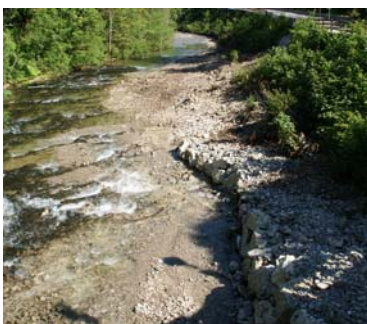
Baggerarbeiten am Seebach
